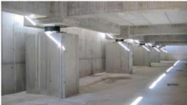
evidente che in una valutazione complessiva costi-benefici debba essere messa in conto anche la drastica riduzione degli oneri di riparazione a seguito dell'eventuale evento sismico. Tali sistemi fanno generalmente riferimento a due principi di protezione: l'isolamento alla base e la dissipazione di energia.
