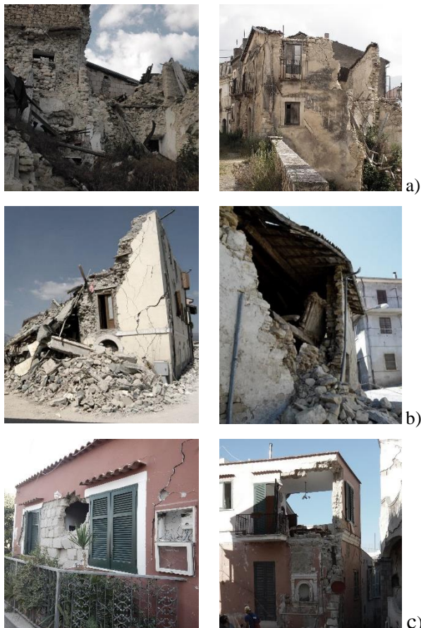
Figura 1. Tipici meccanismi di danno di edifici in muratura osservati nei centri storici di: (a) Poggio Picenze, sisma aquilano del 6 Aprile 2009; (b) Amatrice, evento sismico del Centro Italia del 24 Agosto 2016 (Menna et al., 2016); (c) Casamicciola, sisma dell'Isola d'Ischia del 21 Agosto 2017 (Azzaro et al., 2017).
