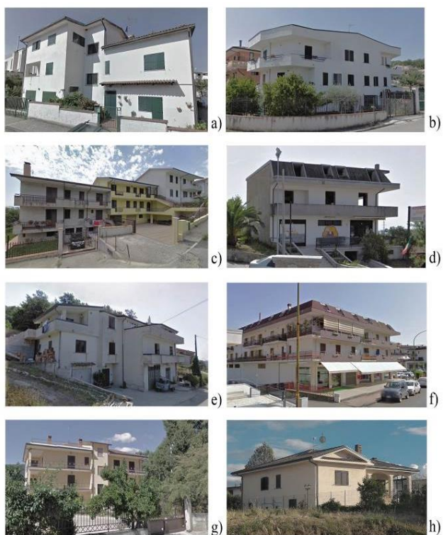
Figura 3. Tipologie di edifici CAR individuate nei comuni di Caiazzo (a), Castel Campagnano (b), Castello del Matese (c), Gioia Sannitica (d), Liberi (e), Piedimonte Matese (f), Pontelatone (g) e Ruviano (h).
