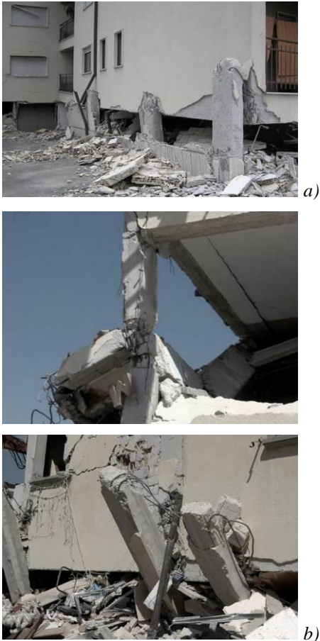
Figura 1. Tipici meccanismi di danno degli edifici in c.a. osservati a: (a) Pettino (AQ), sisma aquilano del 6 Aprile 2009 (Verderame et al., 2009), (b) Amatrice, evento sismico del Centro Italia del 24 Agosto 2016 (Menna et al., 2016).
