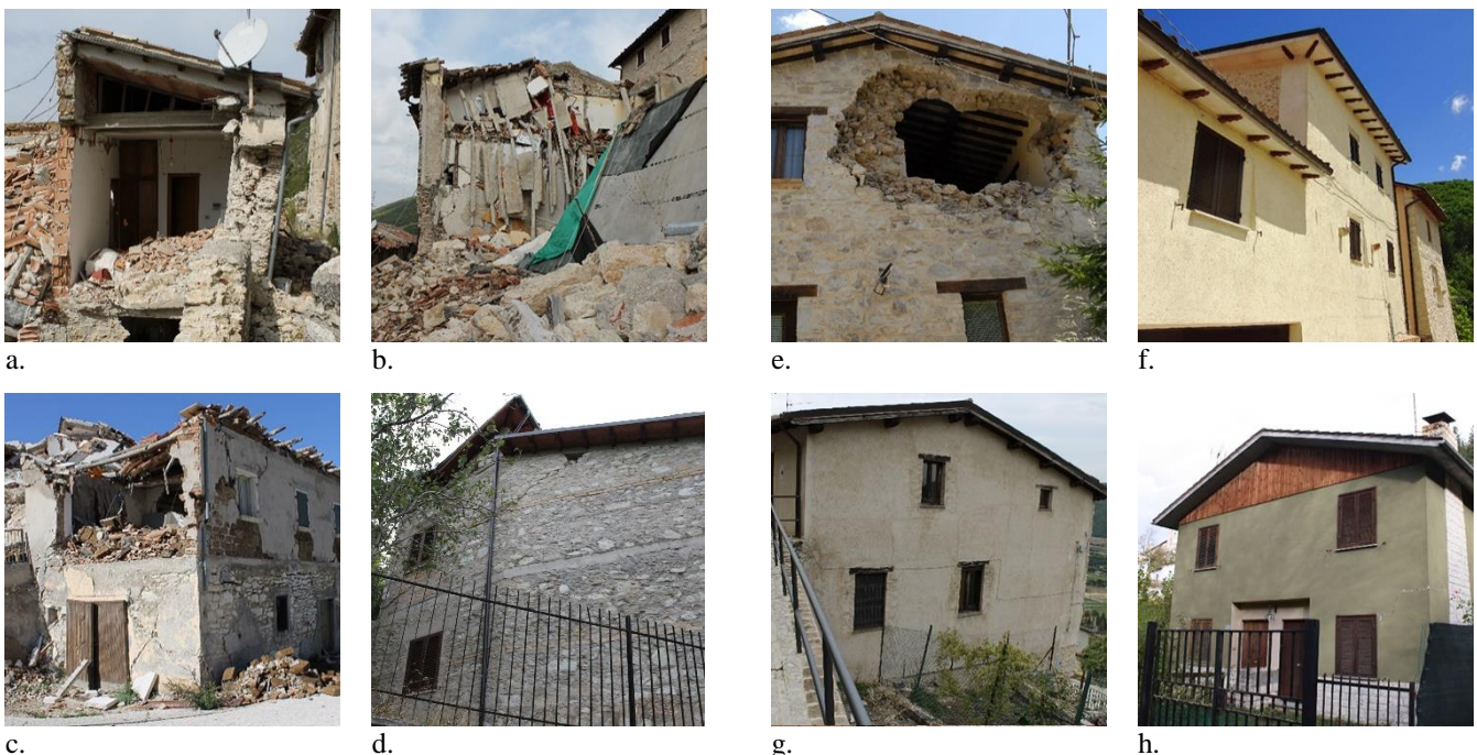
Figura 5. Esempificazioni delle otto categorie derivate dalla combinazione tra strutture verticali e orizzontali, comprendendo il tipo di interventi applicati sulle fabbriche: (a) Muratura non rinforzata o consolidata in modo non efficace con orizzontamenti rigidi e pesanti (Campi Alto di Norcia, PG); (b) Muratura non rinforzata o consolidata in modo non efficace con orizzontamenti semirigidi pesanti (Campi Alto di Norcia, PG); (c) Muratura non rinforzata o consolidata in modo non efficace con orizzontamenti flessibili (Castelluccio di Norcia, PG); (d) Muratura ristilata con orizzontamenti pesanti (Campi Alto di Norcia, PG); (e) Muratura ristilata con orizzontamenti semirigidi pesanti o leggeri (Castelsantangelo sul Nera, MC); (f) Muratura consolidata in modo efficace con orizzontamenti rigidi (Campi Alto di Norcia, PG); (g) Muratura consolidata in modo efficace con orizzontamenti semirigidi (Castelluccio di Norcia, PG); (h) Muratura in blocchi con orizzontamenti rigidi o semirigidi (Castelsantangelo sul Nera, MC).
