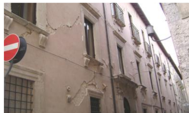
Figura 2. Edifici in muratura "antichi migliorati" (MUR-2) a L'Aquila
