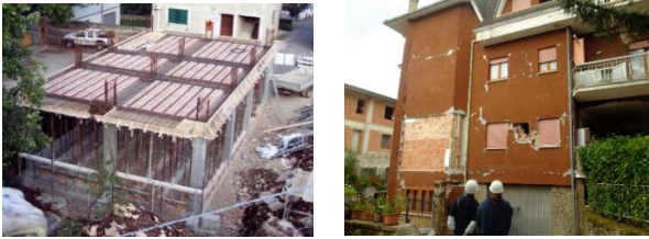
Figura 9. Edifici costruiti dopo l'entrata in vigore delle norme sismiche: a) edifici in costruzione a San Gregorio Magno (SA), b) Amatrice (RI)
