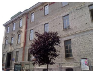
Figura 4. Edificio in muratura "semi-moderno" (MUR-4) a Napoli
