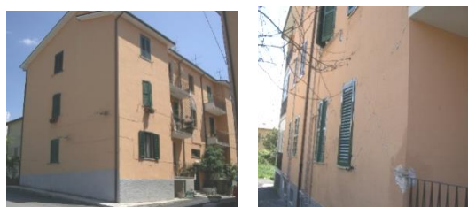
Figura 3. Edificio in muratura "moderno" (MUR-3) a L'Aquila
