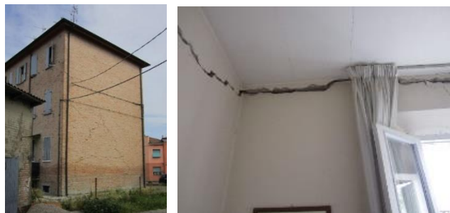
Figura 5. Edificio in muratura "moderno non a norma" (MUR-5) a Mirandola (MO)
