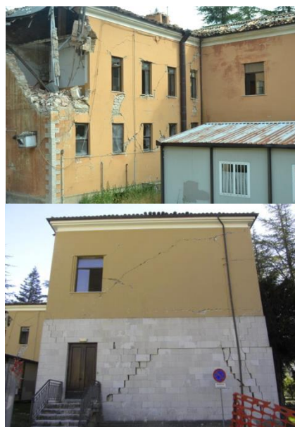
Figura 2. Scuola "P. Capuzi" di Visso (MC) al termine della sequenza sismica che ha colpito il Centro Italia nel 2016/2017 (foto al 8/12/2017): a. vista sulla parete 8 con lesioni a taglio diagonale nei maschi e nelle fasce e sull'angolata della parete 7 in cui si è attivato un meccanismo di ribaltamento dopo la seconda scossa del 26/10/2016; vista sulla parete 10 con meccanismo per scorrimento con deformazioni permanenti significative al piano terra. Per la numerazione delle pareti si rimanda alla Figura 3.
