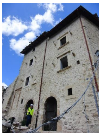
Figura 5. Campi Alto, risposta sismica di edifici con interventi: (a) TIPO 1: edifici con solai in travi Varese e tavelloni di sostituzione su murature non consolidate; (b) TIPO 2: edifici con solai rigidi di sostituzione su muratura non consolidata; (c) TIPO 3: edifici con muratura consolidata solo su alcuni livelli, ricostruita in quello superiore e orizzontamenti qualsiasi (nella foto i solai sono deformabili in legno e mezzane di cotto); (d) TIPO 4: edifici con solai rigidi di sostituzione e murature consolidate.
