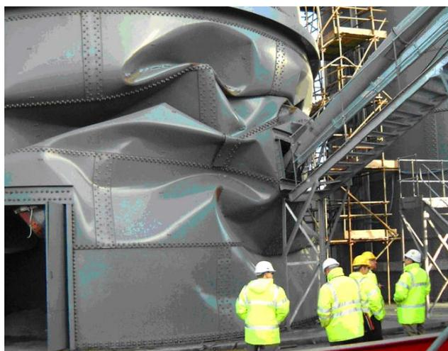
Figura 2. Instabilità del mantello inferiore in un silo in lamiera causata dalla compressione verticale indotta per attrito dal contenuto (immagine tratta dal sito <http://silopressuremeasurements.weebly.com>).
