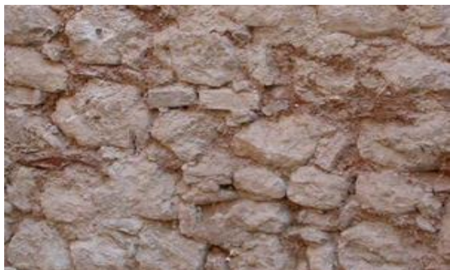
Figura 2. Tessitura muraria, riscontrata all'interno di Palazzo Margherita, realizzata in pietrame disordinato e malta argillosa di basse proprietà meccaniche.
