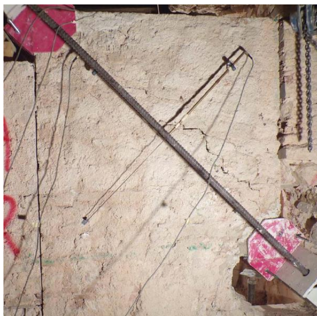
Figura 26. Rilievo del danno al termine del test 1NR, che ha evidenziato come le lesioni del pannello murario di pietrame non rinforzato si sviluppano soltanto all'interno della malta posta tra le unità di pietra.
