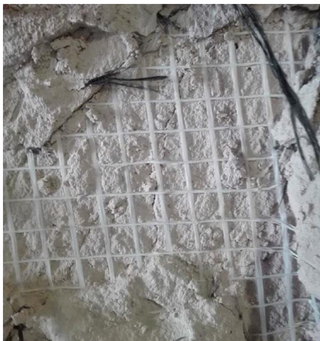
Figura 29. Spicconatura dello strato di rinforzo al termine della prova 4R che ha permesso di rilevare l'integrità della rete in fibra di vetro in corrispondenza delle lesioni del paramento murario e, inoltre, l'aderenza tra la malta di rinforzo ed il supporto.
