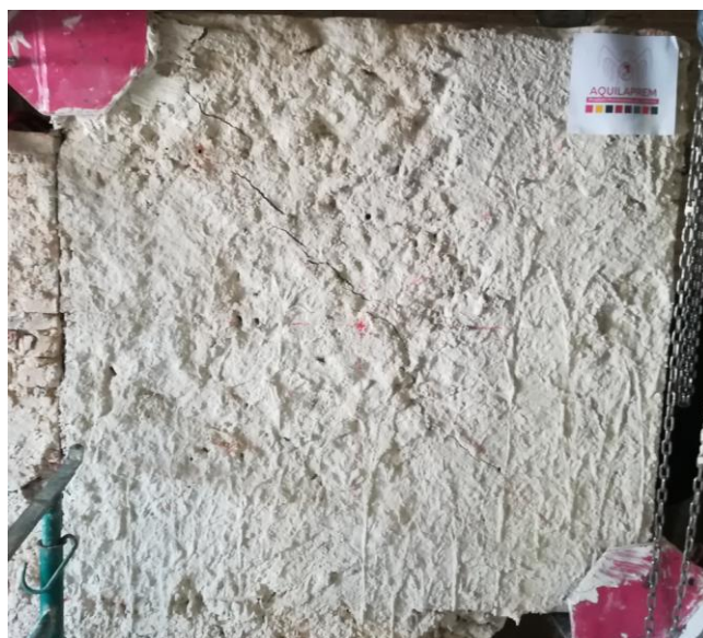
Figura 24. Rilievo delle lesioni al termine del test 4NR, che ha evidenziato come le lesioni del pannello murario di pietrame non rinforzato si sviluppano all'interno delle unità di pietra, le quali restano integre.
