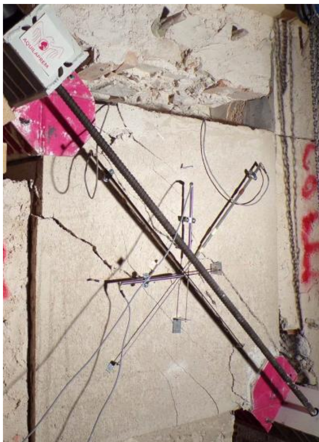
Figura 28. Rilievo delle lesioni al termine del test 3R.
