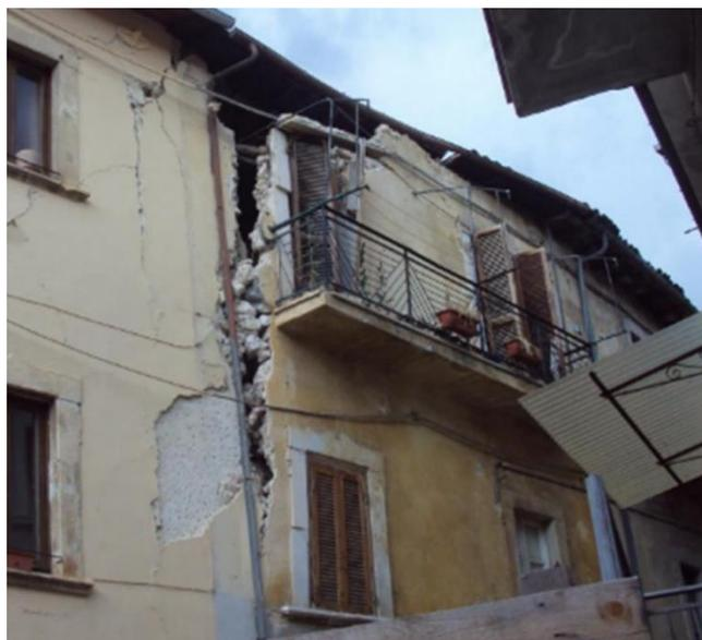
Figura 2. Comportamento di tipo disgregativo di una muratura di pessima qualità in un edificio vicino ad Accumoli (RI) dopo il sisma del 24 agosto 2016 e comportamento di tipo locale, con innesco di un cinematismo di ribaltamento della facciata di un edificio a Tempera (AQ) dopo il sisma del 6 aprile 2009.
