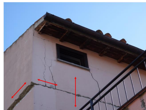
Figura 2. Particolare danneggiamento edificio A
