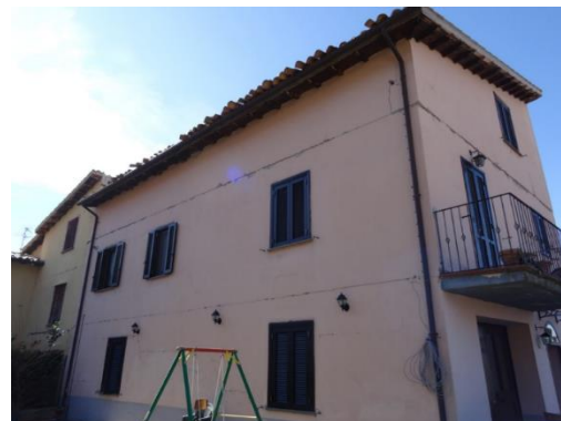
Figura 1. Quadro di danneggiamento edificio A
