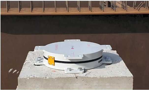
Figura 3. Un isolatore a scorrimento (per gentile concessione di Matildi+Partners, Bologna).
