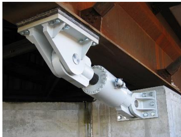
Figura 2. Uno smorzatore viscoso installato su una spalla (per gentile concessione di FIP MEC srl, Selvazzano (PD)).
