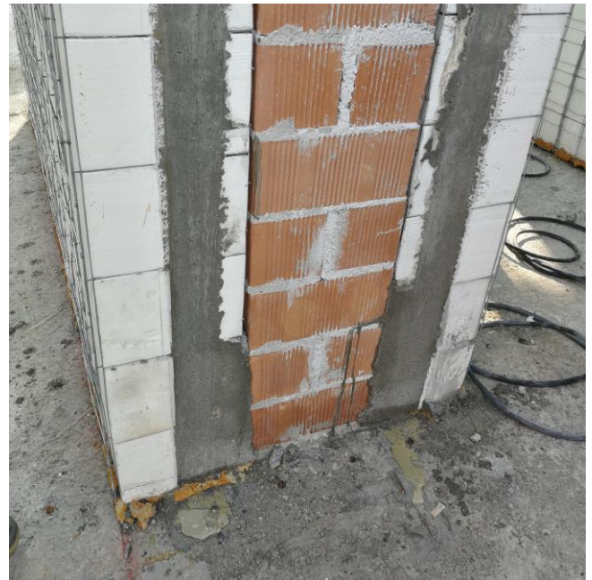
Figura 3. Particolare delle nervature alla base del campione M-1.
