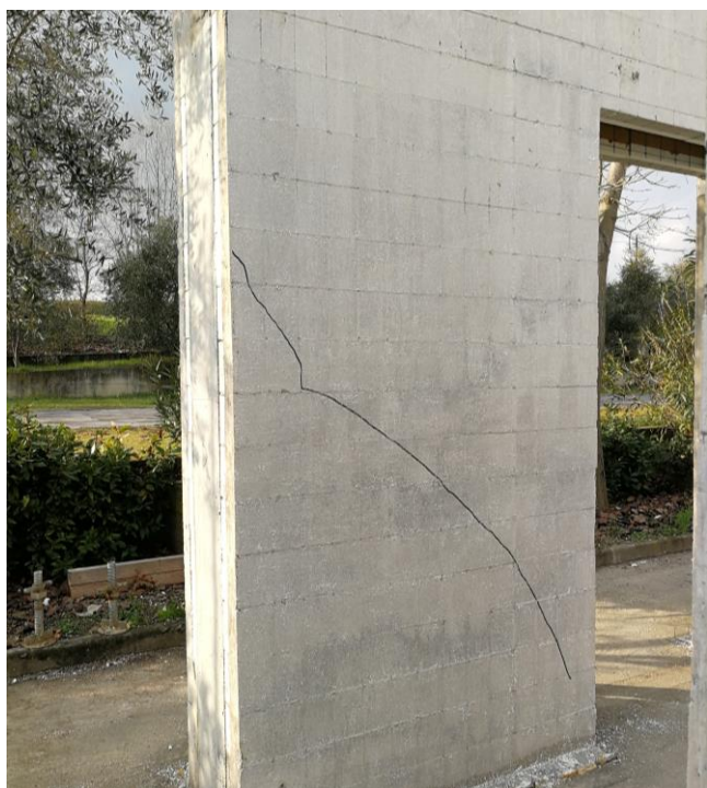
Figura 11. Fessura diagonale osservata ed evidenziata nel campione C-2 al termine dell'esecuzione della prova.
