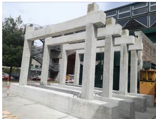
Figura 1. Fasi realizzative dei portali in c.a.: predisposizione gabbia pilastri (a), getto (b), scasseratura (c).
