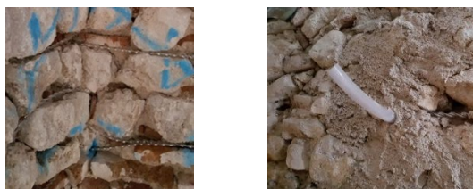
Figura 39 : consolidamento delle giunture con iniezioni di malta di calce idraulica
