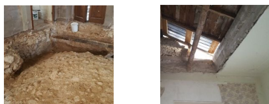
Figura 25 : a) volta in pietra salone piano primo, b) cordolo in cemento armato
