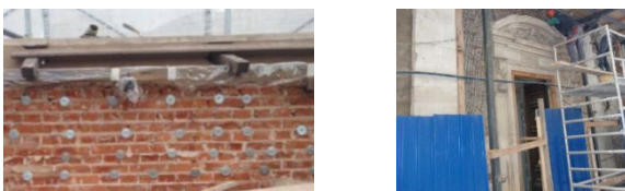
Figura 35 a) a) ricostruzione della vela su via S.Marciano, b) rinforzo della parete su via S.Marciano
