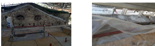
Figura 41 : a) timpano di copertura, b) smontaggio del cordolo in c.a. capsule ad espansione chimica
