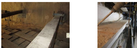
Figura 37 : a) appoggio travi lignee della copertura, b) restauro del cornicione
