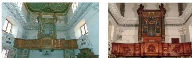
Figura 5 : a) organo prima del sisma del 2009, b) organo dopo il sisma del 2009
