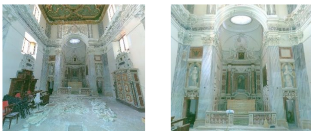
Figura 4 : a) interno dopo il sisma del 2009, b) particolare cupoletta presbiterio
