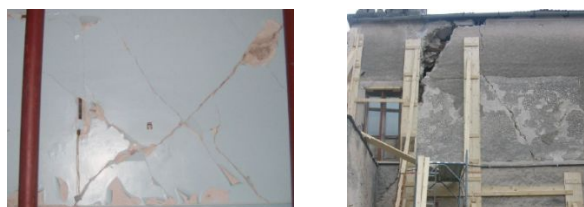
Figura 27 : a) Lesioni da taglio al piano primo, b) piano primo prospetto su giardino
