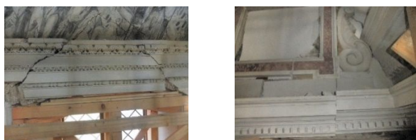
Figura 31 : a) porzione della trabeazione con distacco dal supporto murario, b) fratture e dissesto del cornicione
