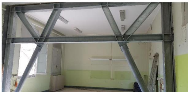
Figura 14. Telai controventanti montanti in cantiere.
