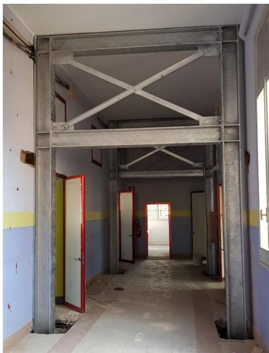
Figura 15. Telai controventanti montanti in cantiere.
