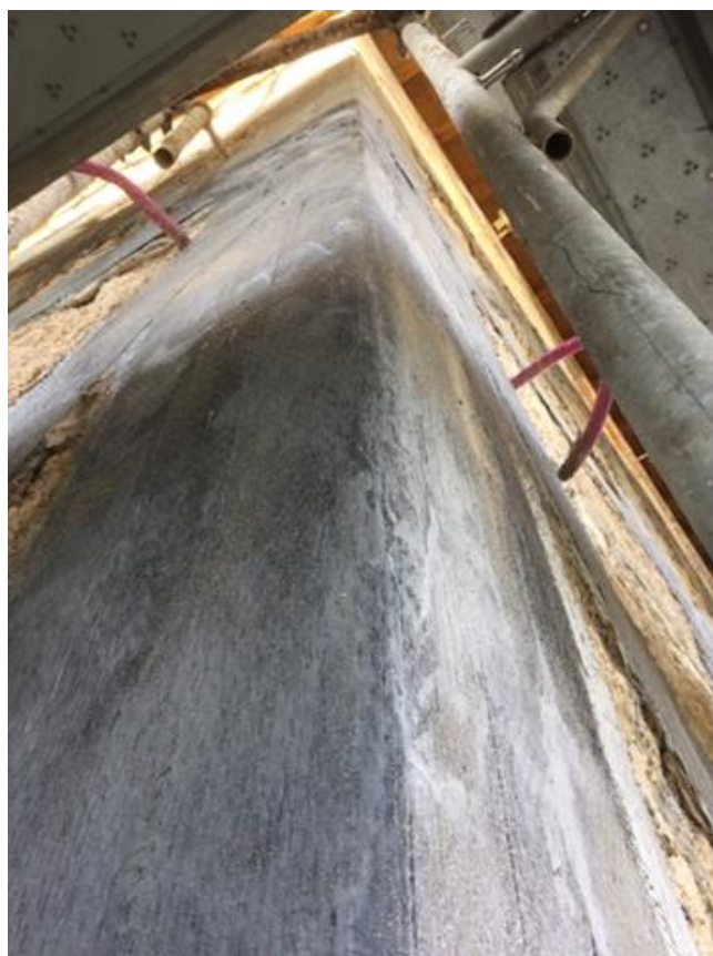
Figura 9. Particolare del rinforzo sullo spigolo esterno.
