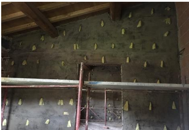
Figura 10. Vista di una parete interna.
