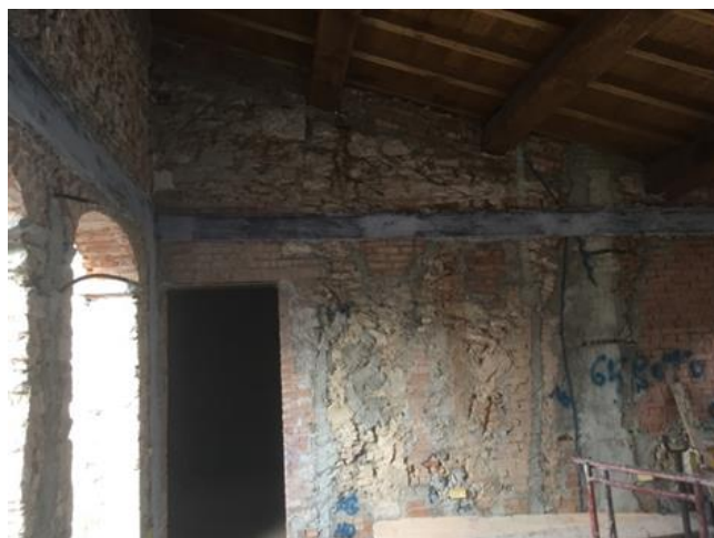
Figura 8. Vista di una catena interna.
