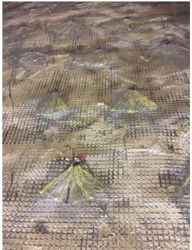
Figura 12. Dettaglio dei connettori.
