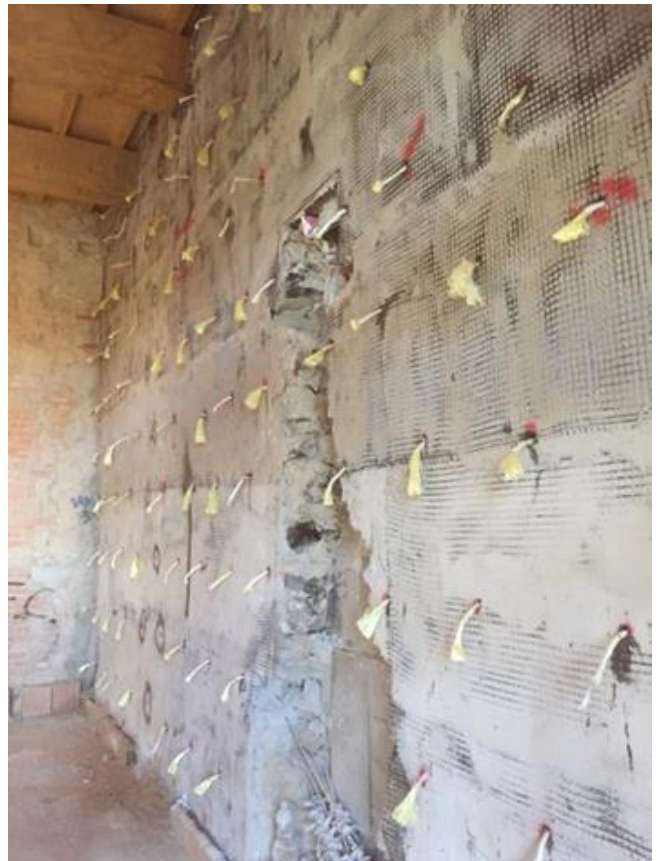
Figura 11. Dettaglio del rinforzo FRCM.
