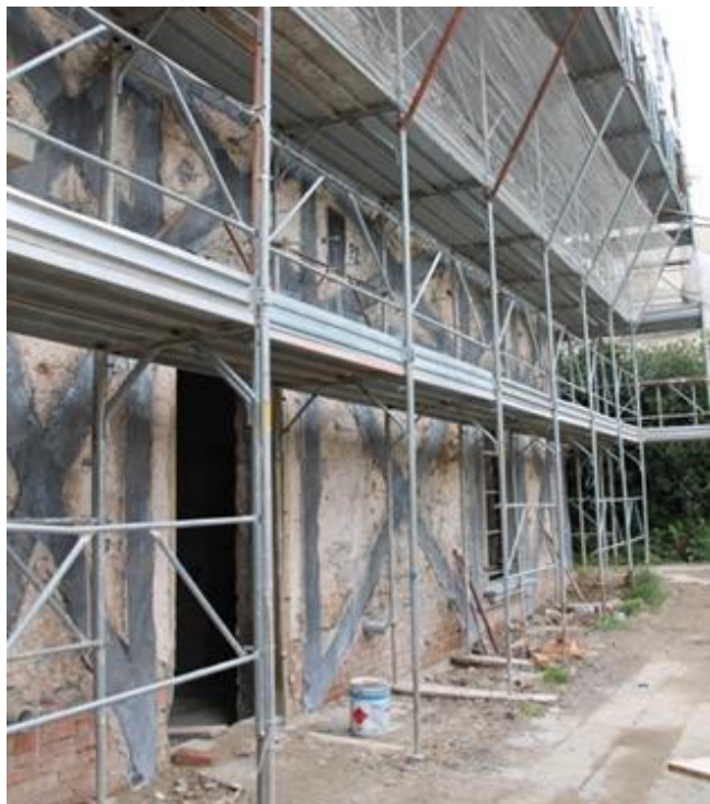
Figura 6. Scorcio della parete esterna rinforzata.
