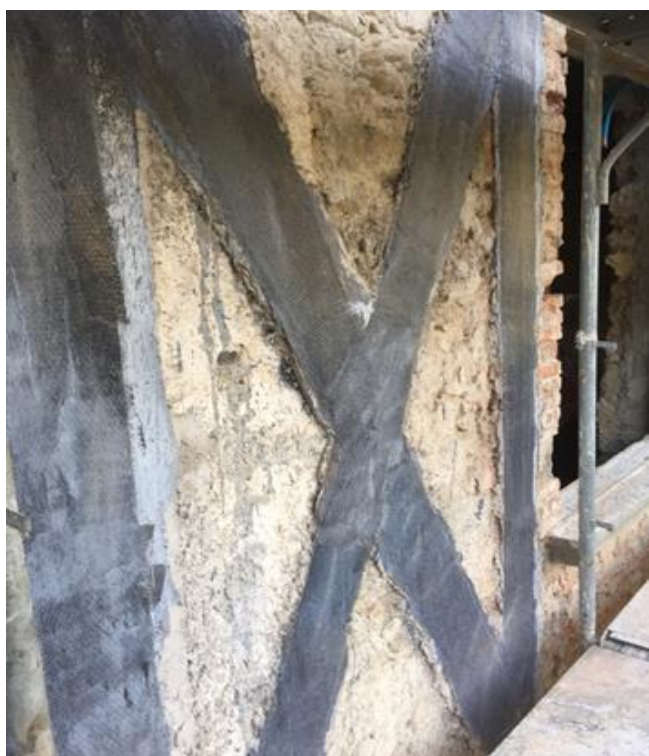
Figura 7. Dettaglio di una Croce di Sant'Andrea.
