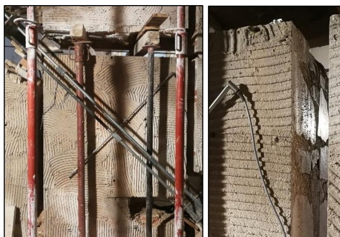
Figura 6. Uno dei campioni testati in Palazzo Cirillo V (AQ). Tutte le superfici murarie si presentavano coperte da una rasatura che ha impedito un'approfondita valutazione della qualità muraria.
