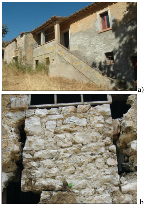
Figura 3. a) Edificio I: casa colonica a Colle Umberto (PG) caratterizzata da una muratura in pietrame disordinato (b).
