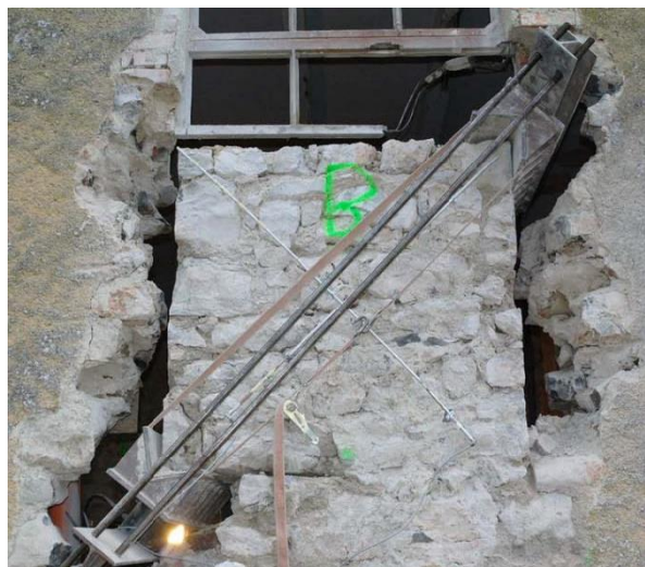
Figura 1. Pannello murario isolato dalla circostante parete attraverso tagli realizzati con una sega circolare e successivamente sottoposto alla prova di compressione diagonale.
