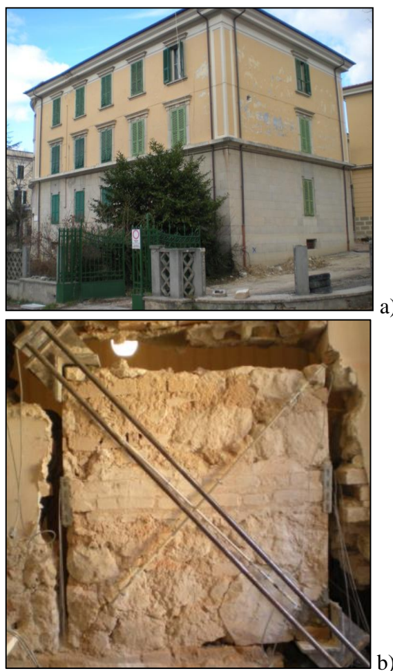
Figura 5. a) Uno degli edifici che costituiscono il complesso condominiale di Porta Napoli a L'Aquila. b) La muratura che caratterizza il complesso è in pietrame disordinato con presenza di listature intervallate 75 cm e realizzate da una doppia fila di laterizi che interessa l'intero spessore murario.
