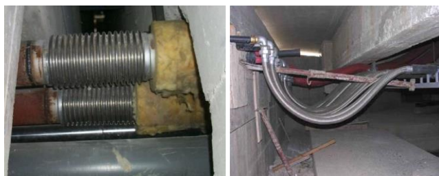
Figura 7 Sistemi di collegamenti impiantistici di tipo flessibile negli interventi di isolamento sismico alla base
