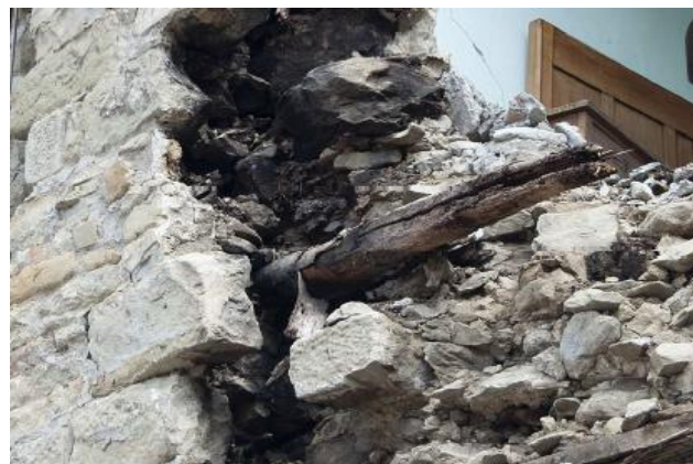
Figura 6. Esempio di muratura con radiciamento. La muratura crollata mostra a vista un nucleo interno alla muratura, di cattiva qualità, con materiali irregolari di piccola dimensione e scarsamente cementati.
