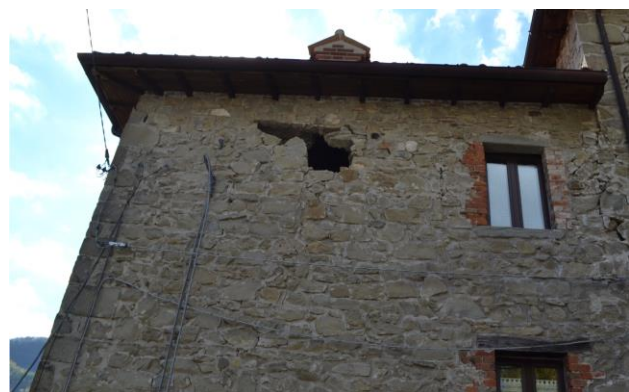
Figura 7. Riprese murarie in corrispondenza delle aperture realizzate in epoche successive alla costruzione originaria con inserti in laterizio. Sono visibili differenti tipologie di architravi.
