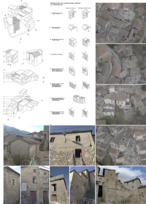
Figura 9. Osservazione dei meccanismi di danno di uno degli aggregati più danneggiati della frazione di Vezzano.
