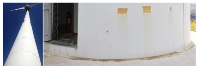
Figura 1. Immagini della torre e particolare delle lesioni verticali alla base del cono di terra
