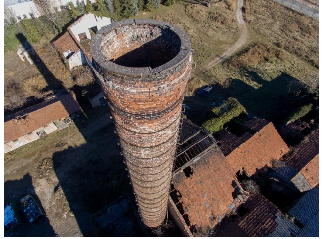
Figura 2. Vista area da drone della parte sommitale della ciminiera.
