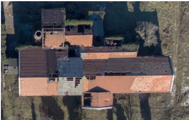
Figura 1. Vista aerea dell'ex-zuccherificio e della ciminiera.
