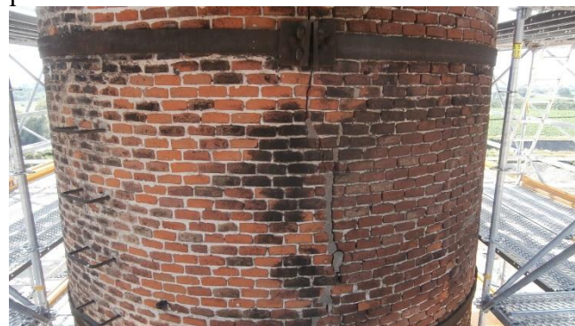
Figura 5. Dettaglio della fessurazione dovuta alla non efficace giunzione delle cerchiature preesistenti.
