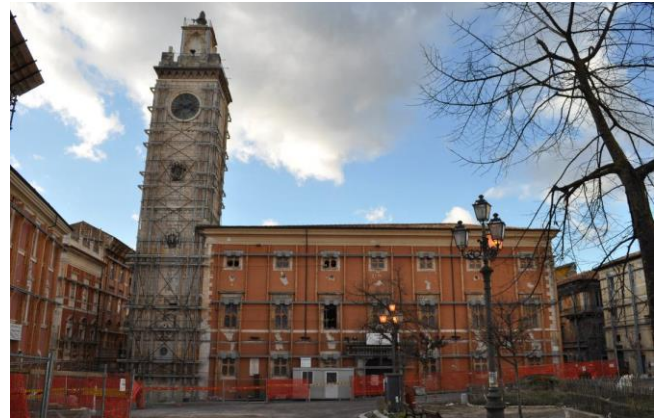
Figura 1. Sede comunale "Palazzo Margherita", edificio fortemente danneggiato dal sisma de L'Aquila 2009.
