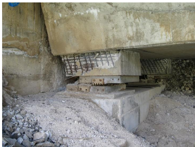
Figura 3: Rottura appoggi mobili e plasticizzazione baggioli a seguito evento sismico del 2009;
