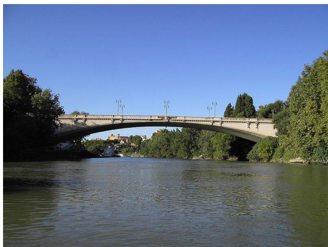
Figura 1. Il ponte Risorgimento a Roma
