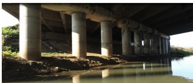
Figura 2. Dislivello pila - spalla
