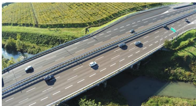
Figura 1. Vista dall'alto del ponte
