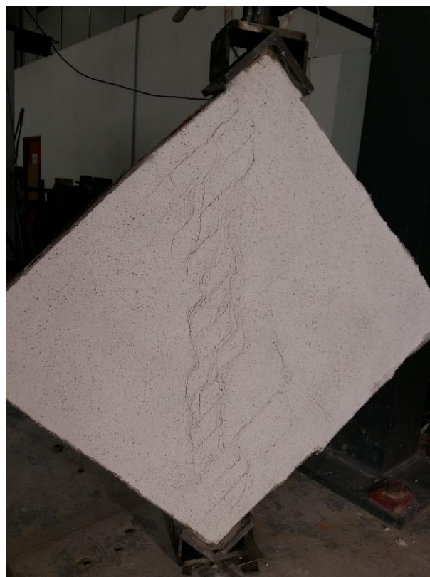
Figura 6. Quadro fessurativo osservato sui muri rinforzati (provino SW-1F-2 )
