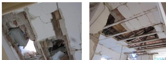
Figura 3. Fotografie del danno all' 8 Dicembre 2016 di S. Cattari e D. Sivori. Collasso di un solaio di latero-cemento al piano primo e di un solaio in putrelle e tavelloni al piano secondo.
