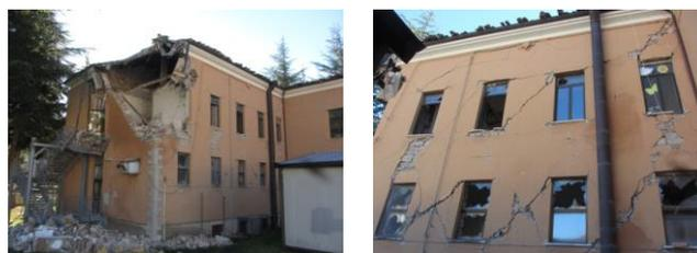
Figura 2. Fotografie del danno all' 8 Dicembre 2016 di S. Cattari e D. Sivori. A sinistra, meccanismo di ribaltamento fuori dal piano. A destra, danneggiamento prevalente a taglio nei maschi e nelle fasce .
