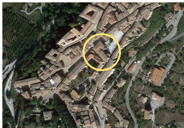
Figura 1: Vista aerea del fabbricato.
