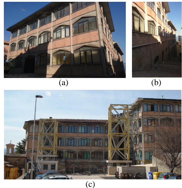
Figura 2: (a) Facciata nord-ovest dell'edificio; (b) Facciata sulla rampa a sud-ovest; (c) retro dell'edificio ad est con le due Torri dissipative.
