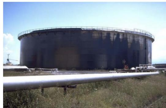
Figura 3. Terremoto di Izmit (Turchia) del 17 agosto 1999 con Mw 7,4 - Tupras refinery: fuoriuscita di idrocarburo a seguito del danneggiamento dell'anello sommitale
