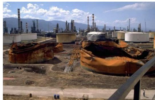
Figura 4. Terremoto di Izmit (Turchia) del 17 agosto 1999 con Mw 7,4 - Tupras refinery: collasso dei serbatoi a seguito dell'incendio provocato dall'innesco dell'idrocarburo esposto
