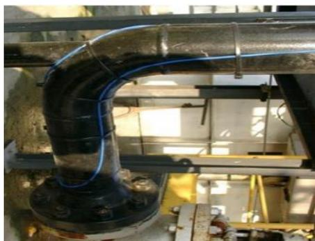
Figura 14. Fibre ottiche applicate su di un gomito per l'identificazione di possibili rilasci di sostanze
