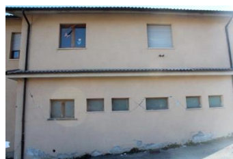
Figura 18. Danno manifestato dalla Scuola elementare e materna "Giuseppe Rizzi" di Montegallo
