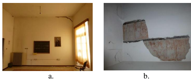
Figura 21. Danno manifestato dall'Istituto Statale Superiore "Gaetano Braga" di Teramo negli orizzontamenti
