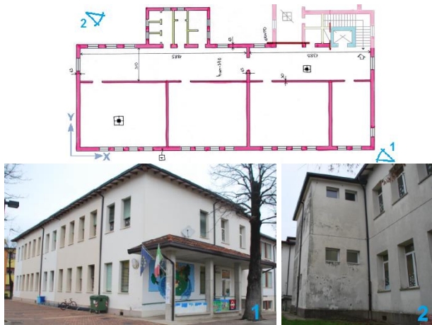
Figura 7. Esempio di edificio scolastico di tipologia 3.
